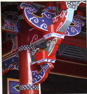
東廡の軒下の櫺型、福建南部の櫺型は蟠龍の形を好むが、流れるような曲線は装飾性豊かである。
